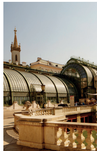
Palmenhaus im Burggarten Palm House in the Burggarten
